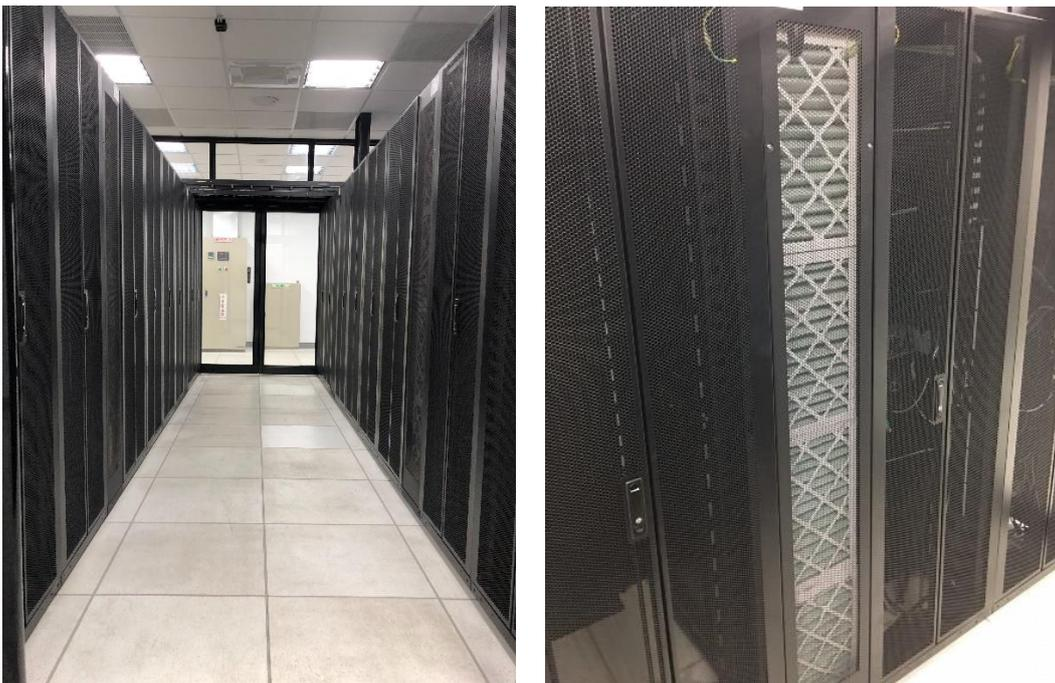
圖 7. 獨立機櫃式冷熱通道空調系統(提供良好之 PUE 值)
